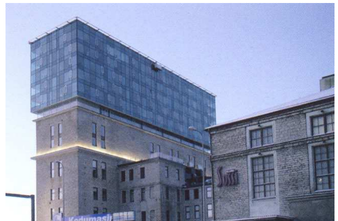
Eksempel på en høj bygning med en arkitektonisk tung nederste del og en let og lys øverste del. Fahlé House, Tallinn. Ark. KOKO.
