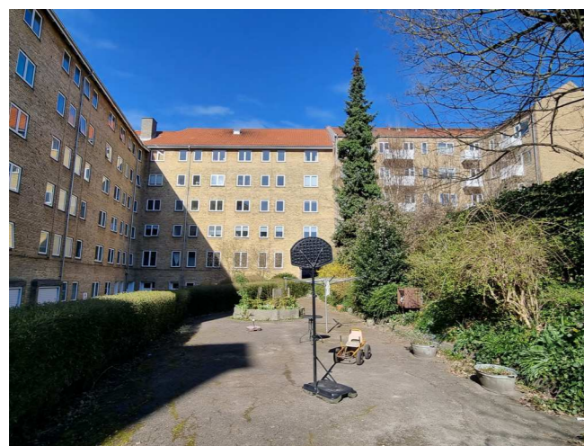
Eksisterende forhold Foto: Københavns Kommune
