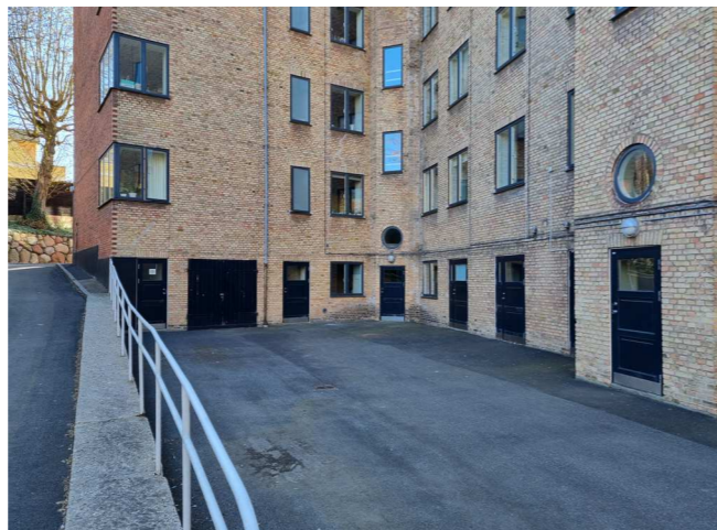
Eksisterende forhold Foto: Københavns Kommune
