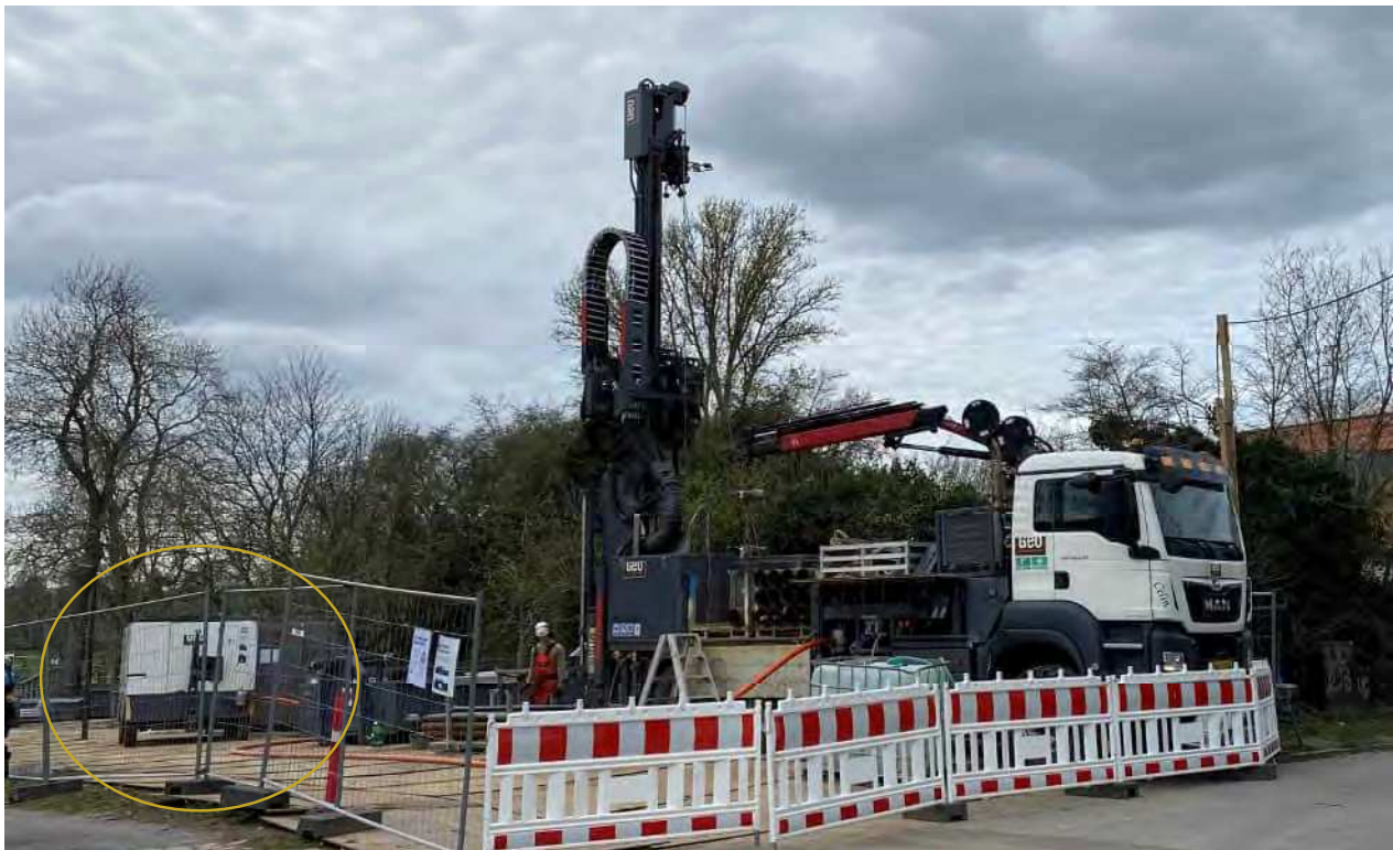
Figur 12-1: Geoteknisk boremaskine monteret på lastbil, samt generator, der er markeret med en gul cirkel.
