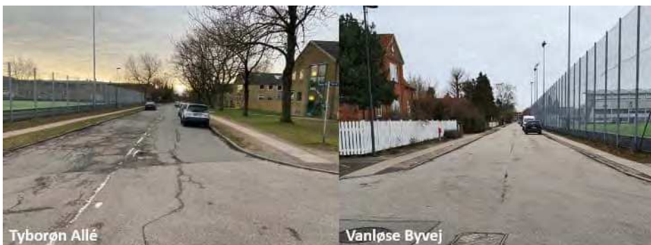
Figur 22: Kantstensparkering på henholdsvis Tyborøn Allé (t.v.) og Vanløse Byvej (t.h.). [Sweco 14.12.2024]
