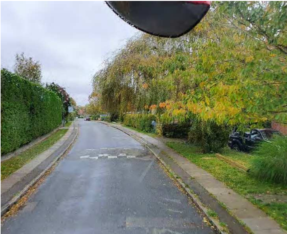
Figur 57: Beplantning som hænger ud over kørebanen på Kildeløbet. [Sweco 23.10.2023]
