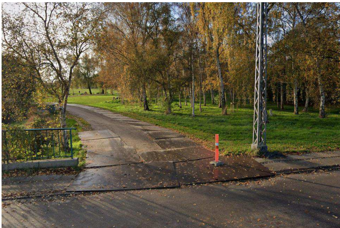
Figur 10-9 Ind- og udkørsel til projektlokaliteten fra Jyllingevej. Bemærk gittermasten der begrænser adgangsforholdene.
