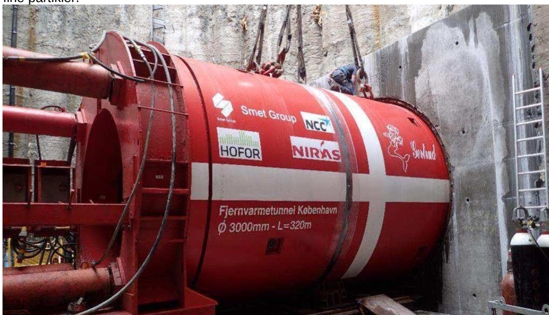
Figur 4-10 TBM er klar til pipe-jacking
