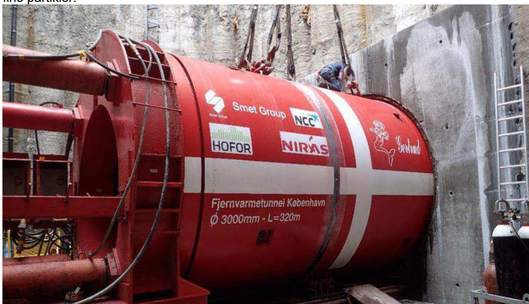
Figur 4-10 TBM er klar til pipe-jacking
