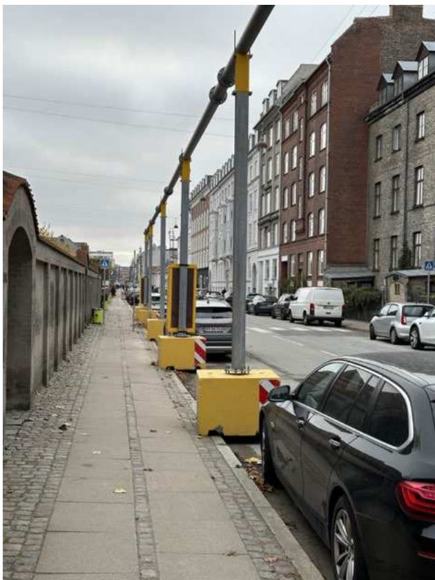
Figur 8: Eksempel på en hævnning af en ledning, hvor der sker grundvandssækning. Setup på Damhusengen kommer til at minde om ovenstående situation, men vælges endeligt af den udførende entreprenør.
