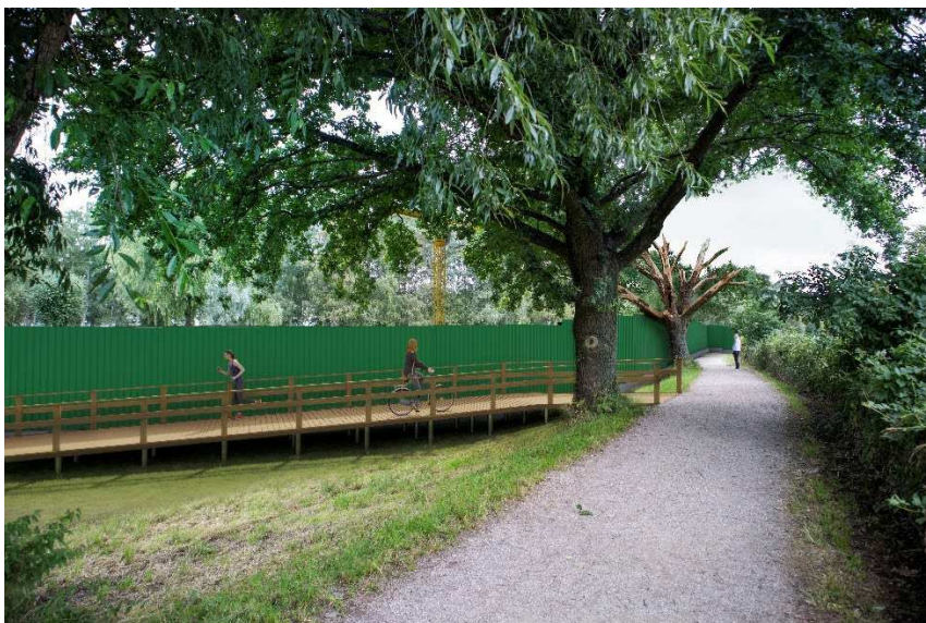
Figur 5: Visualisering af hvordan gangbroen kommer til at synes i området under udførelsesfasen. Der ses op mod fra Damhusengen og op mod Jyllingevej. Grundet distance fra broen til terræn forventes det nødvendigt på denne del af stisystemet, at der skal etableres en håndliste. På den resterende del af stisystemet forventes dette ikke at være nødvendigt. Gangbroen kommer til at være opstillet i hele anlægsfasen.
