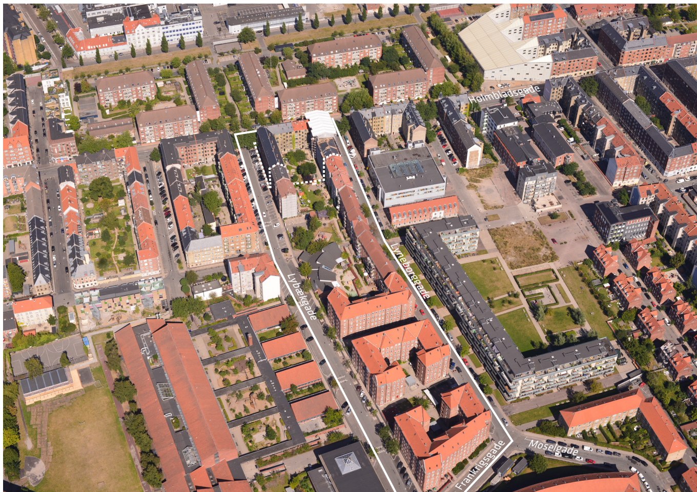
Luftfoto af området set fra syd. Lokalplan nr. 187 er angivet med hvid linje. Området for tillæg nr. 1 er angivet med hvid, stiplet linje.
