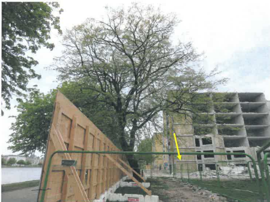
Avnbøg på kanten af Sølund, set fra vest. Bemærk placering af grønt beskyttelseshegn (pil). Kronen rager længere ud end hegnet, og det gør rodzonen sikkert også. Men hegnets placering udgør et acceptabelt kompromis.
