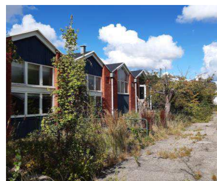
Eksisterende bevaringsværdigt byggeri der omdannes til boliger - tidligere TO-R Radio.
