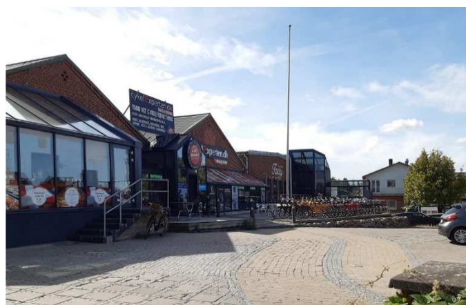
Eksisterende byggeri på Slotsherrensvej 111, med tilbygningerne til det erhverv, der i dag er på grunden. Starten på terrænfaldet ses ved støttemuren.
