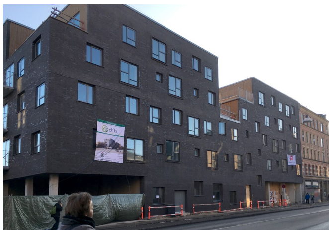
Ny og eksisterende bebyggelse i lokalplanområdet, ud mod Holmbladsgade
