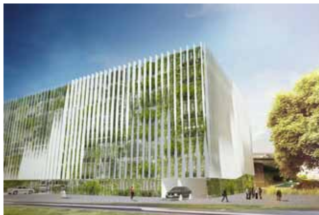
Visualisering af P-hus i byggefelt IIIa, set fra Edel Saantes Allé. Parkeringshusets facade består af drejede udspændte net med planter. Det giver bygningen et organisk udtryk, der går i dialog med Fælledparken. P-huset vil i årets mørke timer være belyst for at skabe en imødekommende atmosfære og trykthed for besøgende. Illustration fra vinderprojekt.
