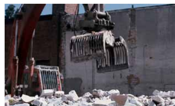
NEDRIVNING AF BYGNING
