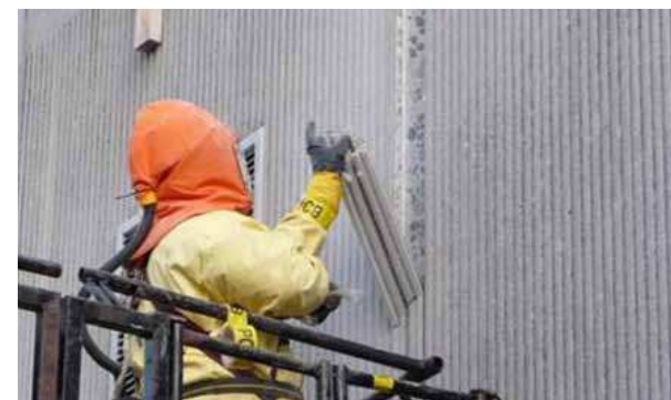
RENSNING AF BYGNING INDEN NEDRIVNING
