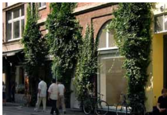
Markant facadebegrønning i kantzonen. Skindergade - København.
