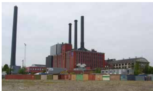
H. C. Ørstedværket set fra øst mod vest. Værket udgør med sin markante arkitektur et væsentligt landmark i planen.
