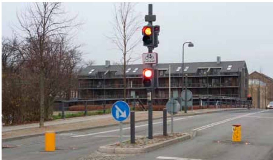
Den mekaniske bussluse syd for Frederiksholmsbroen.
