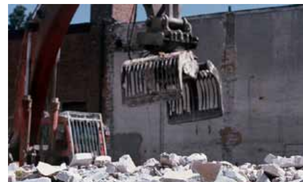
NEDRIVNING AF BYGNING
