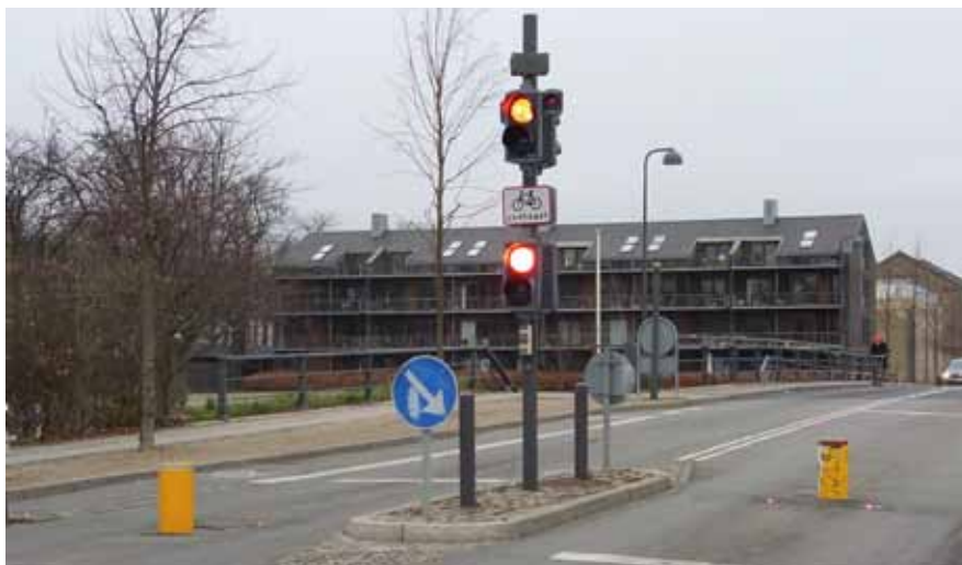
Den mekaniske bussluse syd for Frederiksholmsbroen.
