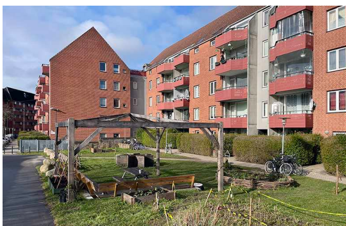
Etageboliger med altaner mod syd og haver i stuelejlighederne. Billedet er set mod vest fra gårdrum mod Sigynsgade i Den Grønne Trekant.
