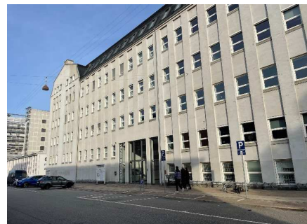
4. Fabriksbygninger opført mellem 1921-1942, der udpeges som bevaringsværdig.
