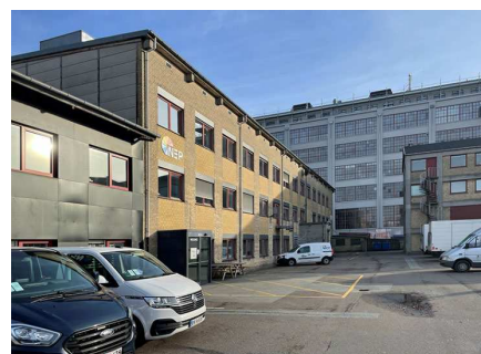
9. Fabriksbygning fra 1952, der udpeges som bevaringsværdig.
