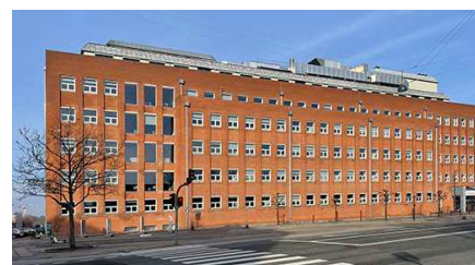
2. Ombygget administrationsbygning for Lauritz Knudsens Fabrikker på Haraldsgade, udpeges som bevaringsværdig.
