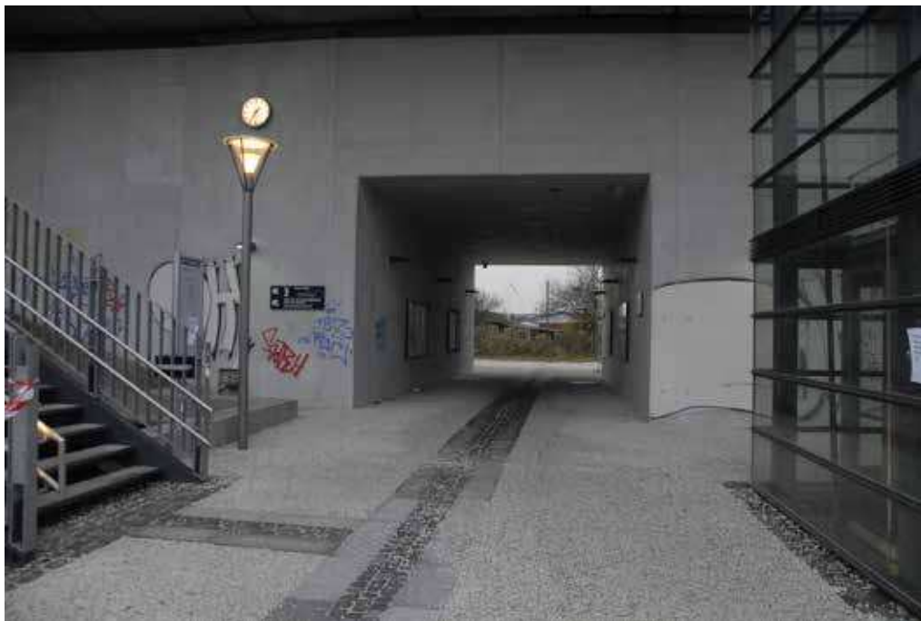
Foto, der viser forbindelsen under Køge Bugt-banen mellem Ny Ellebjerg Stations vestlige og sydlige forplads.
