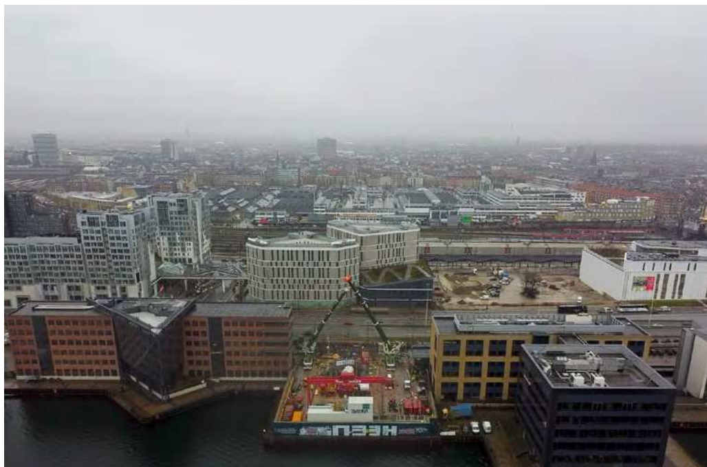
Boreskanten på Kalvebod Brygge Skybrudstunnel med byen i baggrunden
