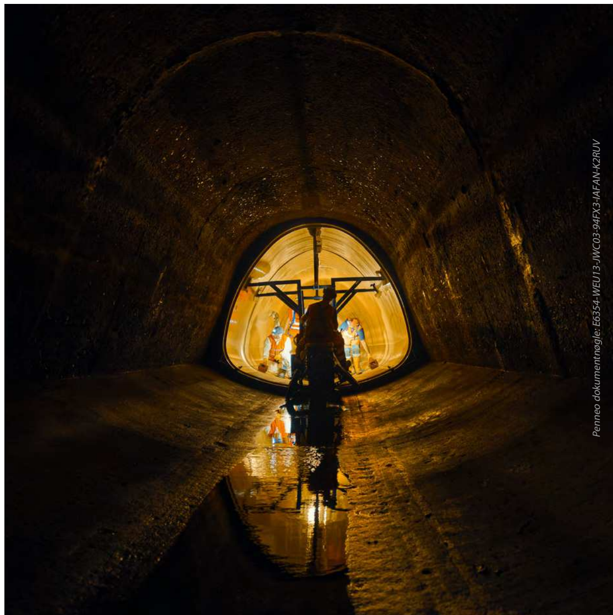
Belvedere-kloakledningen under Hovedbanegården, København
