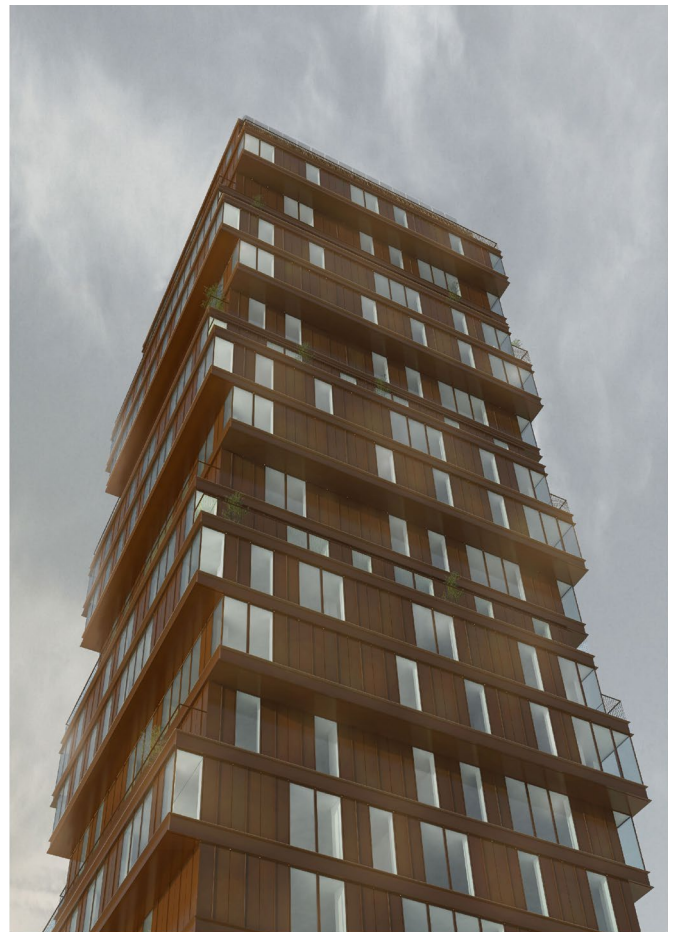
Udsnit af højhuset med ca. 1 meter forskydninger i etageplanerne op gennem bygningen. Illustration: Over Byen Arkitekter.
