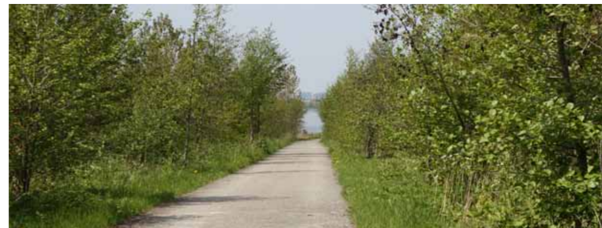
Figur 7.2 Sti ned mod Kalvebodløbet, som forbinder promenaden ved Kalvebod Fælled via en bro over Amagermotorvejen.
