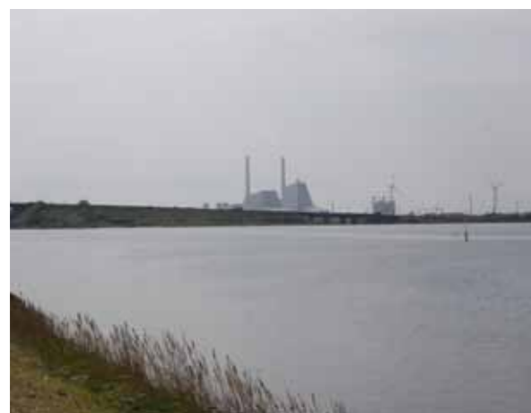
Figur 9.3 Kalvebodløbet set mod syd vest med udsigt til Amagermotorvejen, der krydser løbet til Skrædderholmen. Avedøreværket ses midt i billedet og til højre vindmøllerne på Avedøre Holme.
