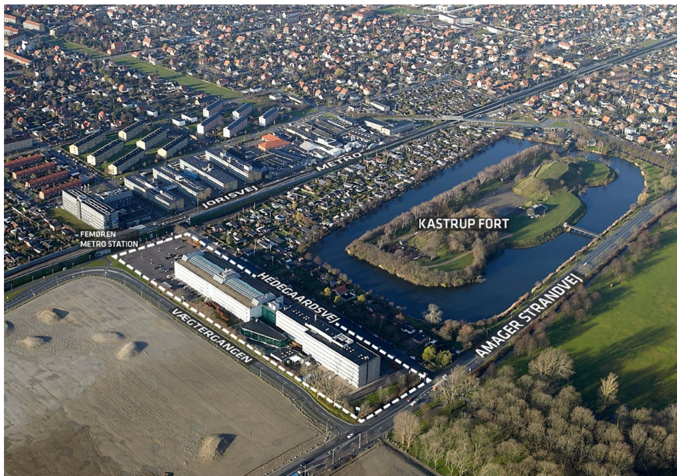
Luftfoto fra december 2014 set mod nordvest med lokalplantillægsområdet markeret med hvid stiplede linje (JW Luftfoto).
