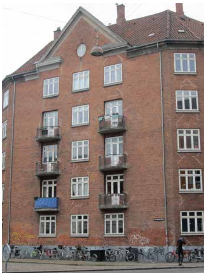
Bygningsfornyelse Centrale Vesterbro 2015
