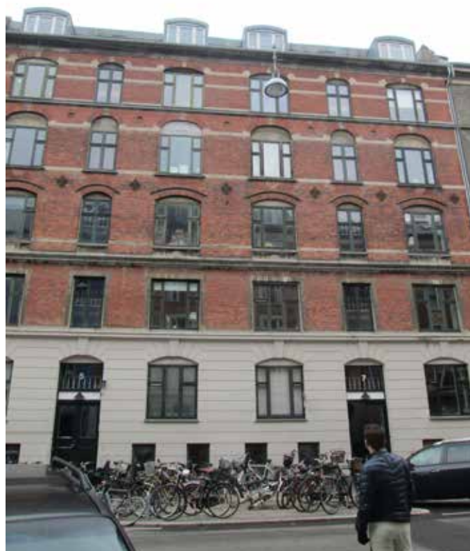
Bygningsfornyelse Centrale Vesterbro 2015
