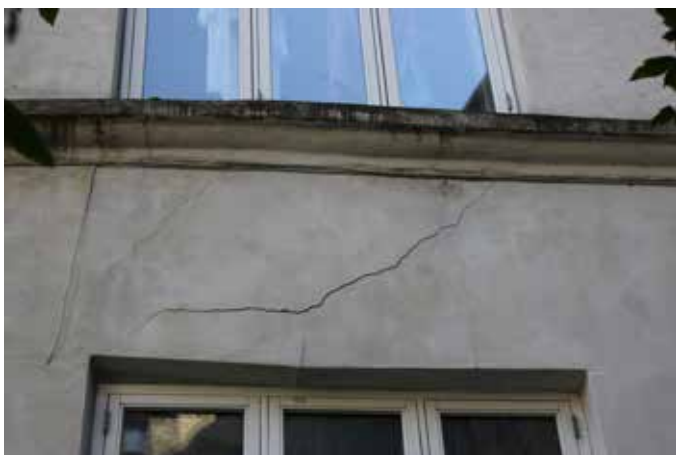
Revner i facade istandsættes og tættes
