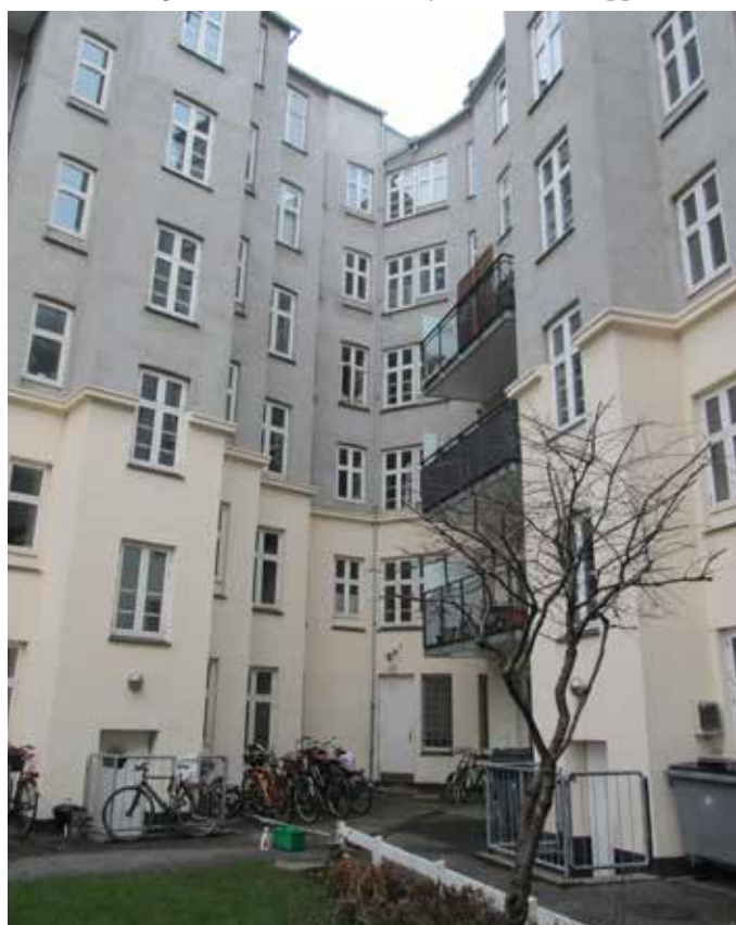
Bygningsfornyelse Centrale Vesterbro 2015
