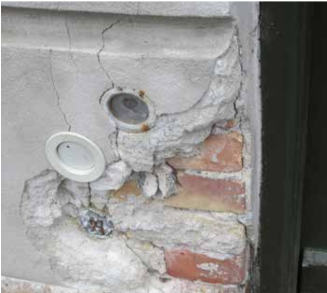
Facader istandsættes og tætnes
