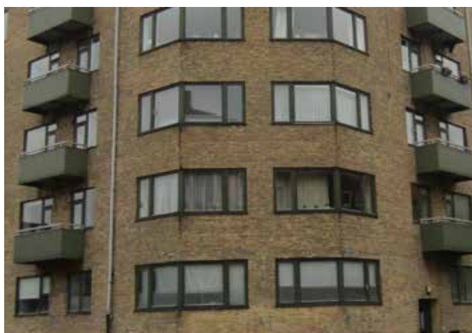
Ældre termovinduer udskiftes til lavenergi med støjisolering
