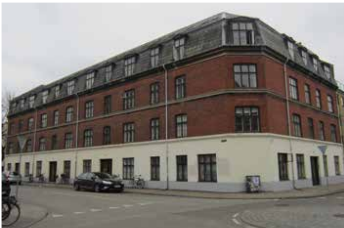
Forhusets facader mod Hejrevej og Ørnevej
