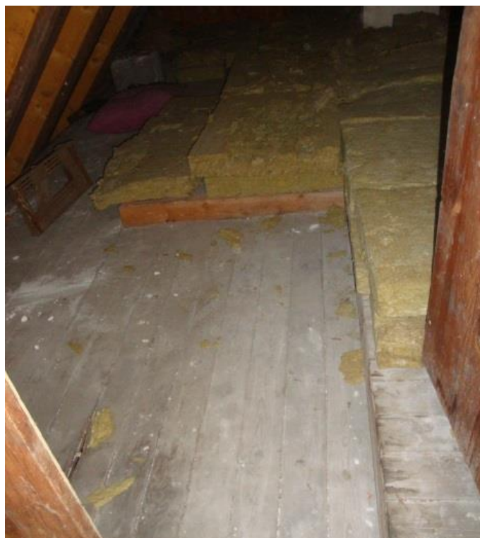
Etageadskillelsen på loftet efterisoleres
