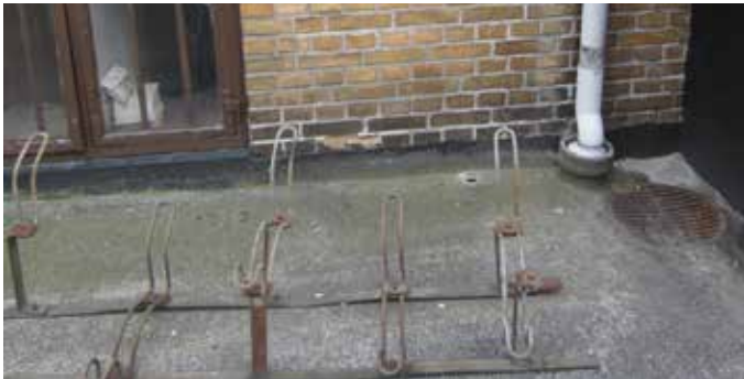
Fundament på forhus fugtsikres og isoleres
