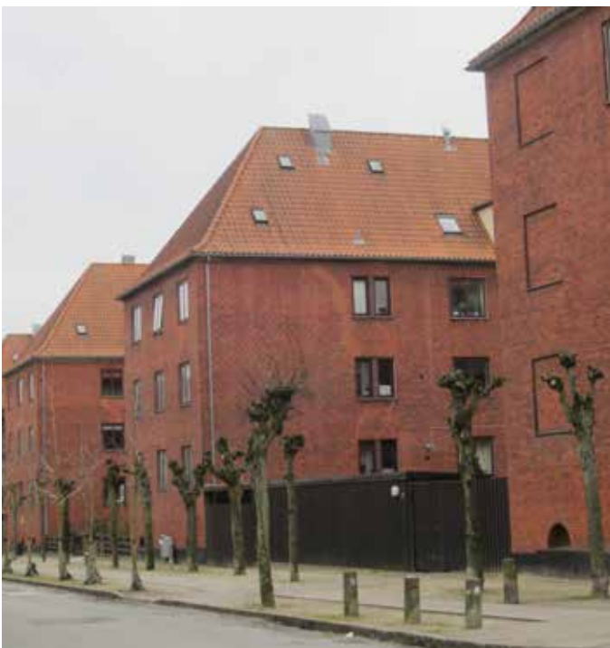
Facader mod Rørsangervej
