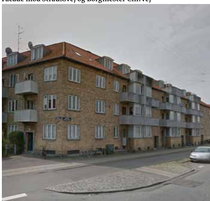
Utætte vinduer udskiftes til støjreducerende vinduer Facade mod Straussvej og Borgmester Chr. vej
