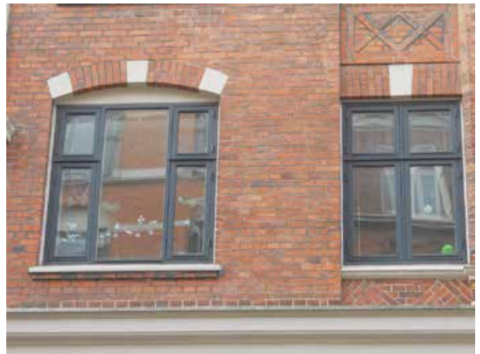
Udskiftning af utætte vinduer til energioptimerede vinduer
