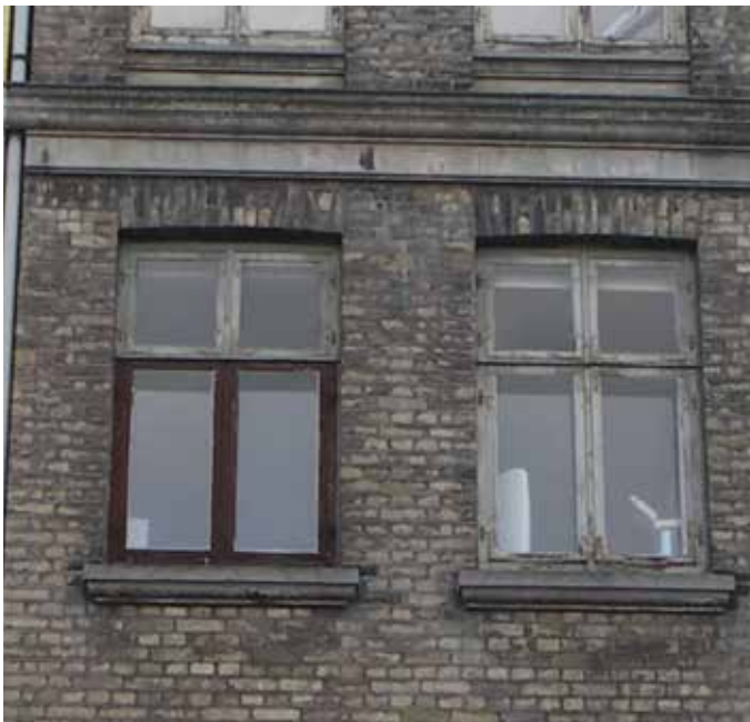
Nedslidte vinduer mod gade udskiftes og støjisoleres
