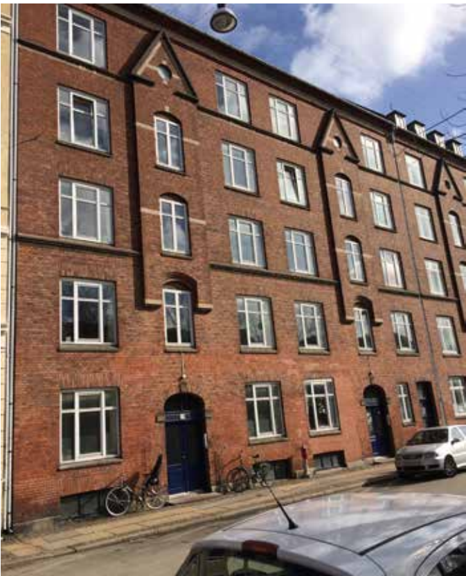
Facade mod Hørsholmsgade
