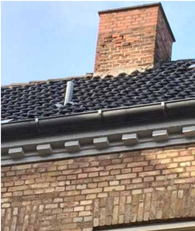
Nedslidt tegltag udskiftes til nyt med isolering Facader mod Frederikssundsvej og Holcks Plads
