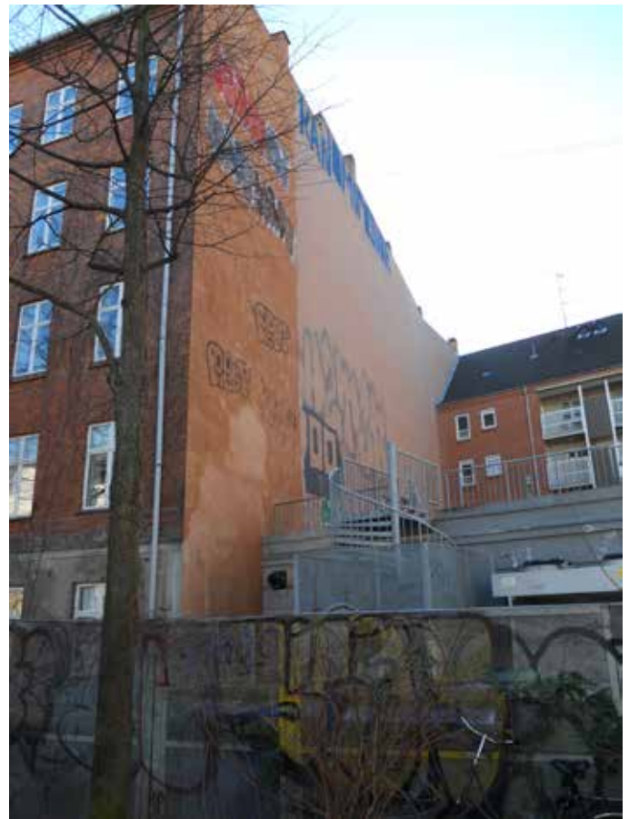
Stor uisoleret bagvant isoleres
