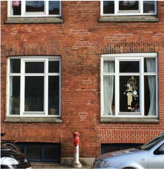
Vinduer udskiftes til lydisolerende energivinduer
