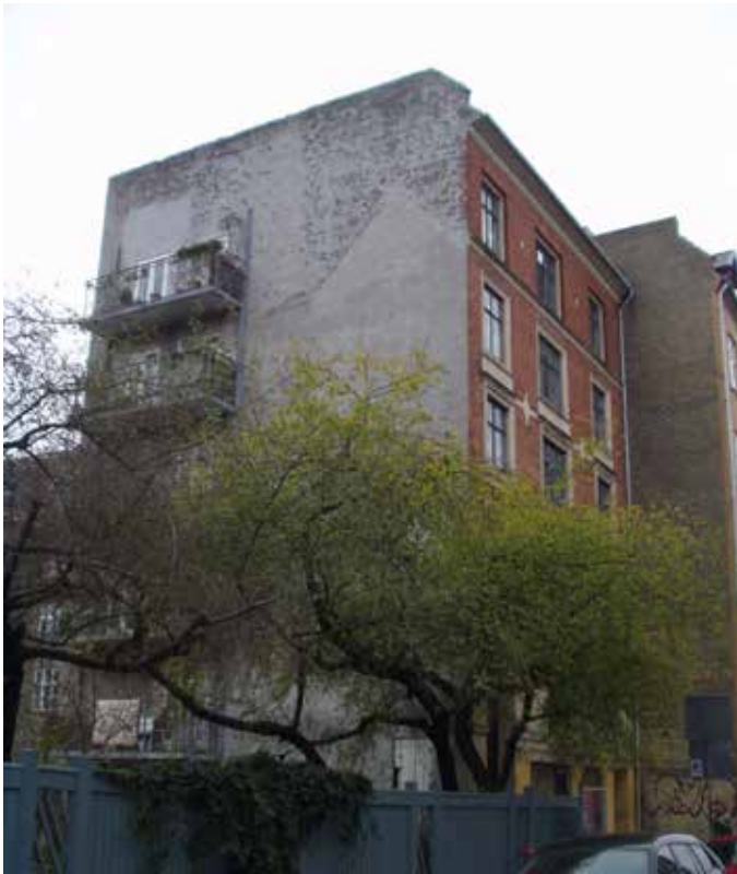
Gavl mod gårdside efterisoleres
