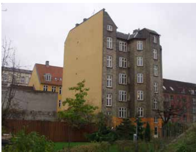
Baghuset får udskiftet vinduer og nyt tag
