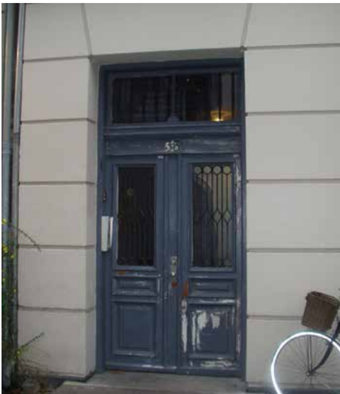
Facader og hoveddøre istandsættes og tættes
