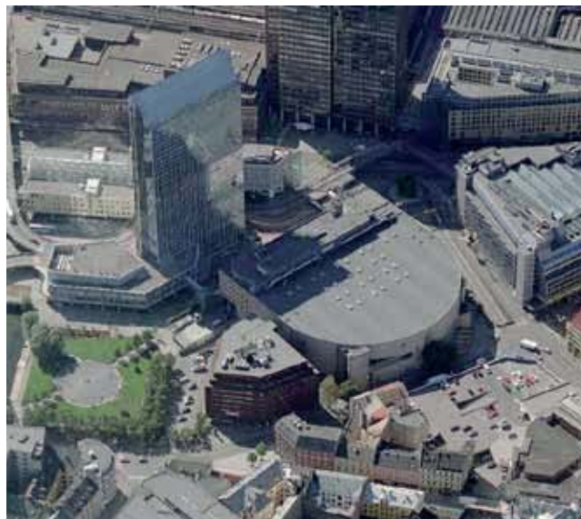
Spektrum Arena i det centrale Oslo med ca. 10.000 tilskuerpladser ligger integreret i byen. Den bliver i dag brugt 70 % til kultur og underholdning (koncerter, tv-shows mv.) og 30 % til sport, salgsmesser og kongresser.
