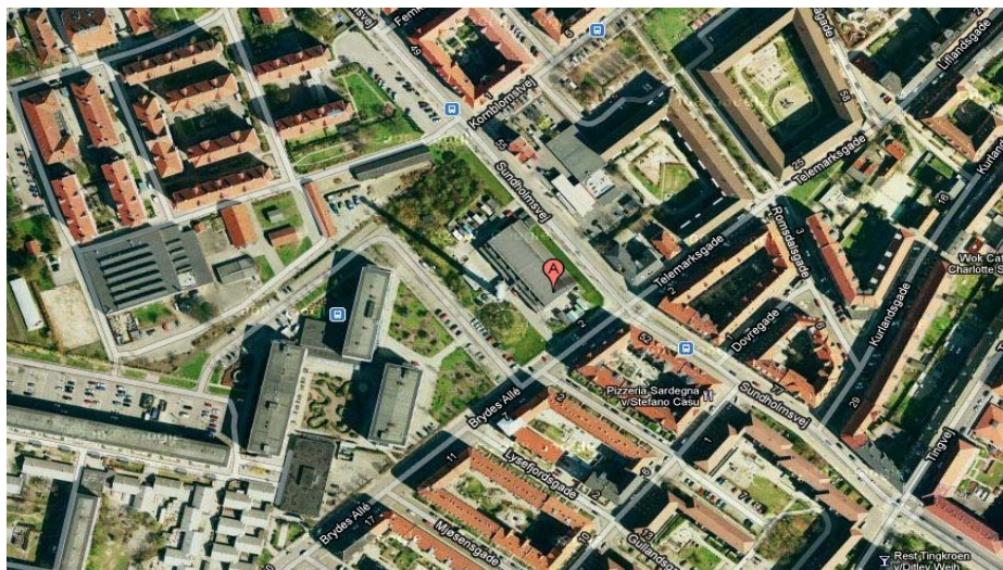
Figur 1. Sundholm Varmecentral og de nærmeste omgivelser. Foto taget før opførelsen af distriktsbygning
