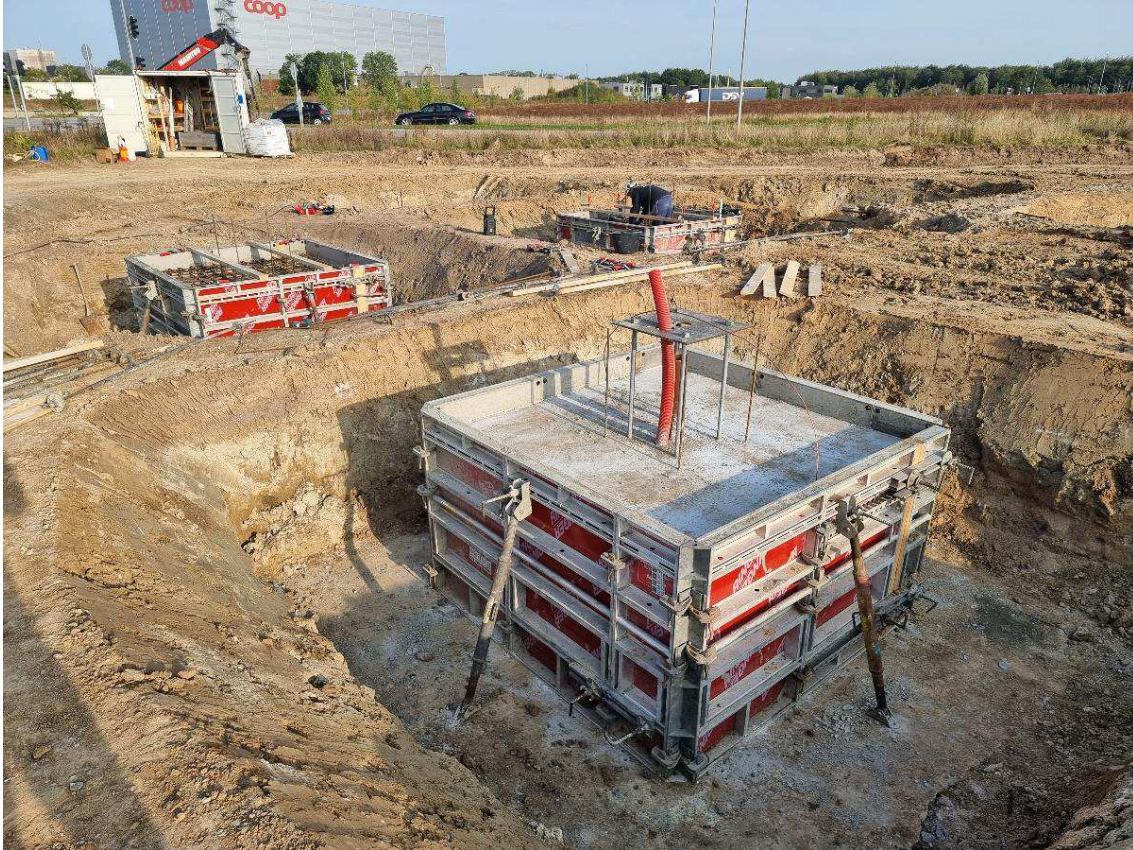
Billede fra byggepladsen ved lynladestation Odense, hvor der støbes punktfundamenter til i alt 28 baldakiner.
