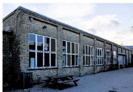
Engvej 145 - Fabriksbygning opført i 1961.
