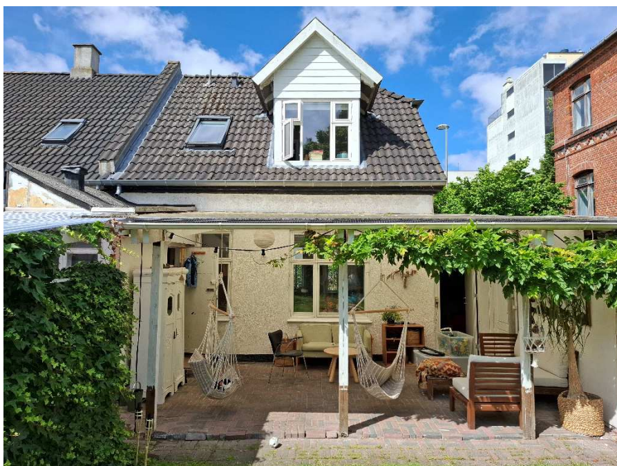
Set fra baghaven med overdækninger
