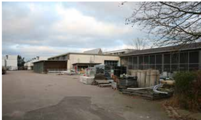
Eksisterende værkstedsbygninger på lokalplanområdet
