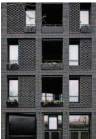
Tegl som grid material.
