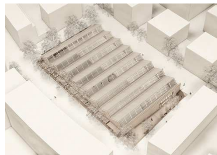
Toldkammerets shedtagskonstruktion bevares, og der etableres plint og halvtæg langs en del af facaden. Illustration: Team Cobe.
