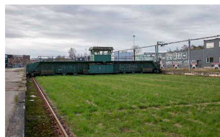
28. Skydebroanlæg, broer, førerhus og spor.
