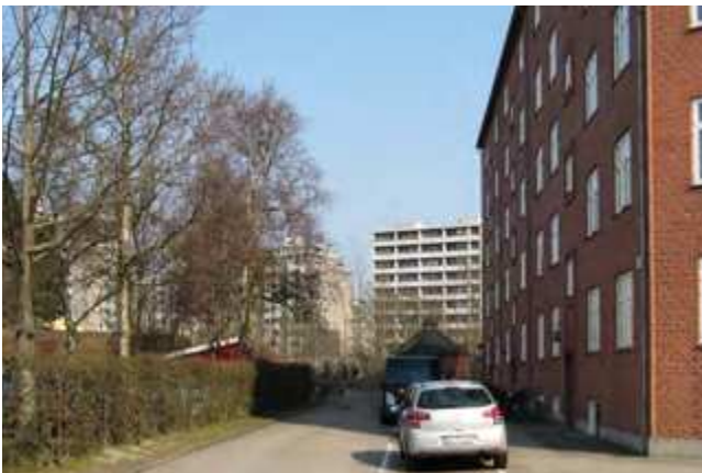
Foto 8 - Vue mod lokalplanområdet fra Næsbyholmvej.
