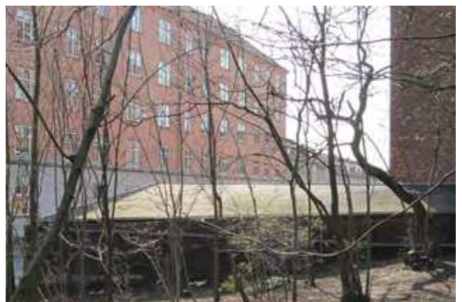
Foto 12 - Ringholmsvej set fra lokalplanområdet
