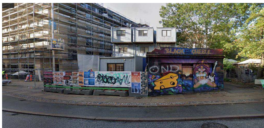
Billede 1: Bygning og adgangsvej ved Enghavevej nr. 8 (t.h. for containere)
