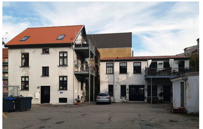
Eksisterende byggeri i gårdrummet på den modsatte side af den bevaringsværdige ejendom.
