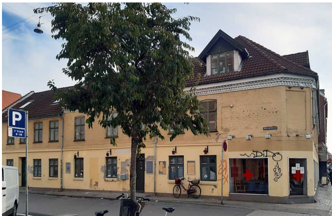
Bygningens facade set fra hjørnet af Middelgrundsvej og Amagerbrogade.
