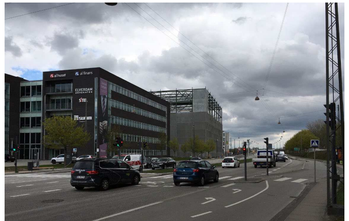
Kontorbygning mod vejen Sjællandsbroen og den nye skole i baggrunden.
