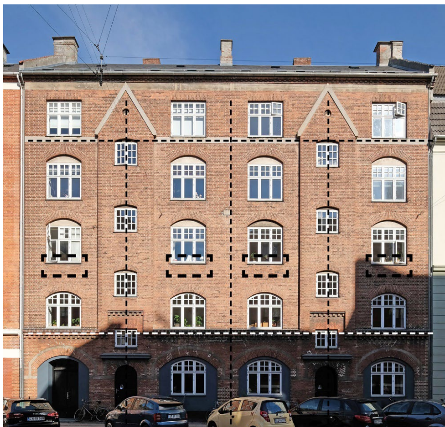
Bygning fra 1905 SAVE-værdi på 4
