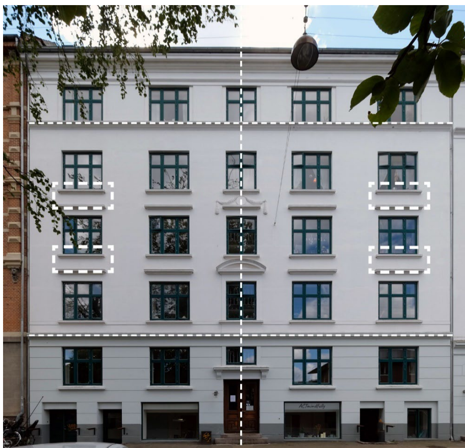
Bygning fra 1902 SAVE-værdi på 4
