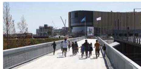
En bred men let konstruktion skaber sikkerhed og tryghed for brugerne på den nye stibro der forbinder Ørestad Syd og Ørestad City.
