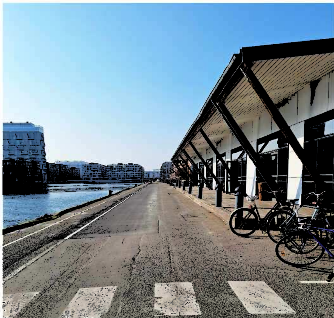
Sundkaj - Det lange stræk langs kajanten som kendetegner Sundmolen.
