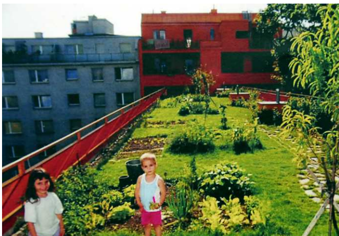
Reference 7.7. Grønt tag med regnvandsforsinkelse og opholdsmulighed.
