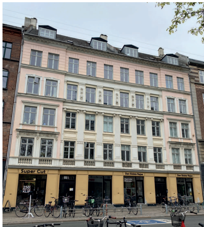
Ejendommen set fra gaden
