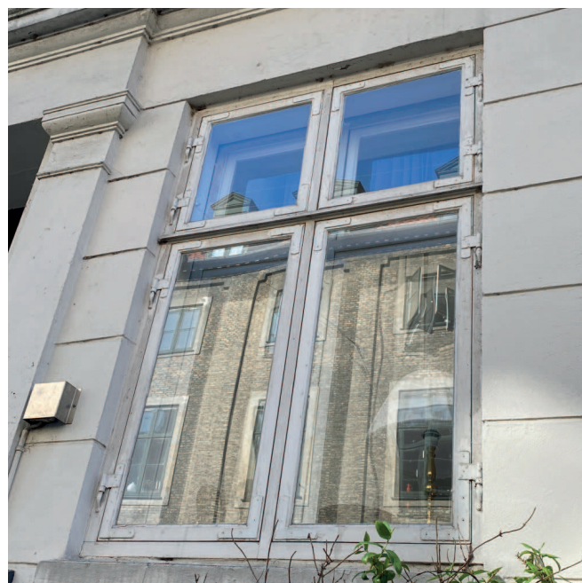
Der udføres snedker gennemgang af vinduer MKB, BYGNINGSFORNYELSE
