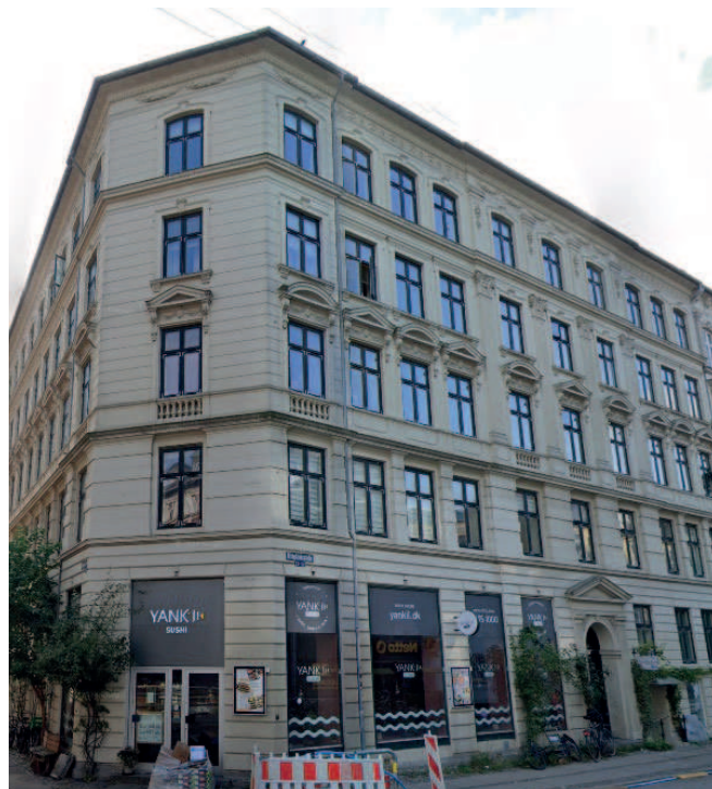
Ejendommen set fra gaden
