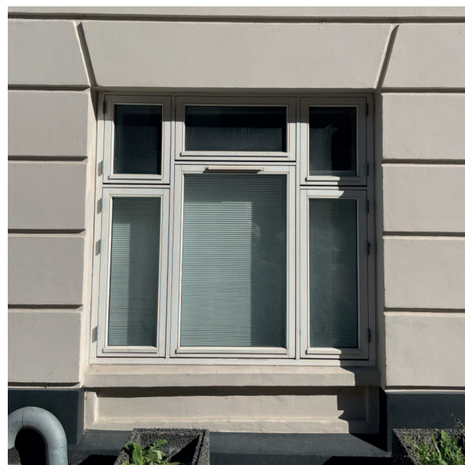
Udskiftes til vinduer tættere på det oprindelige udtryk
