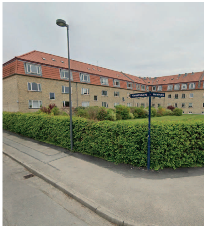
Ejendommen set fra gaden
