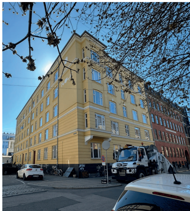
Ejendommen set fra gaden
