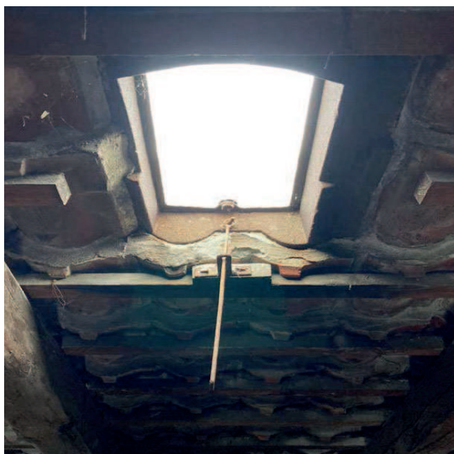
Tag renoveres og efterisoleres
