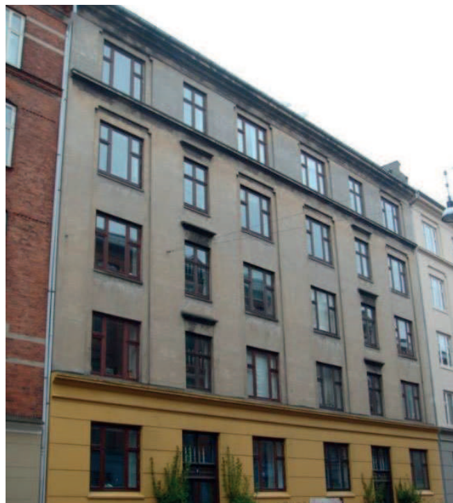
Ejendommen set fra gaden
