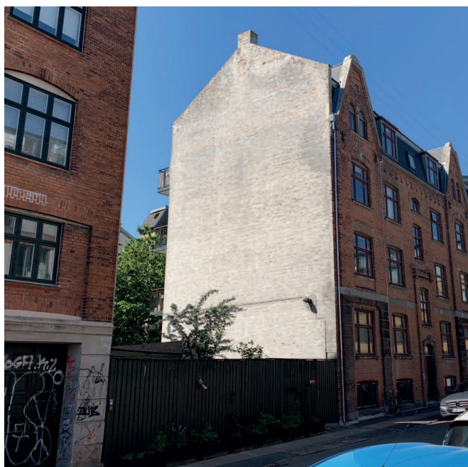
På gavl etableres 'Nordic Green Climate Wall'
