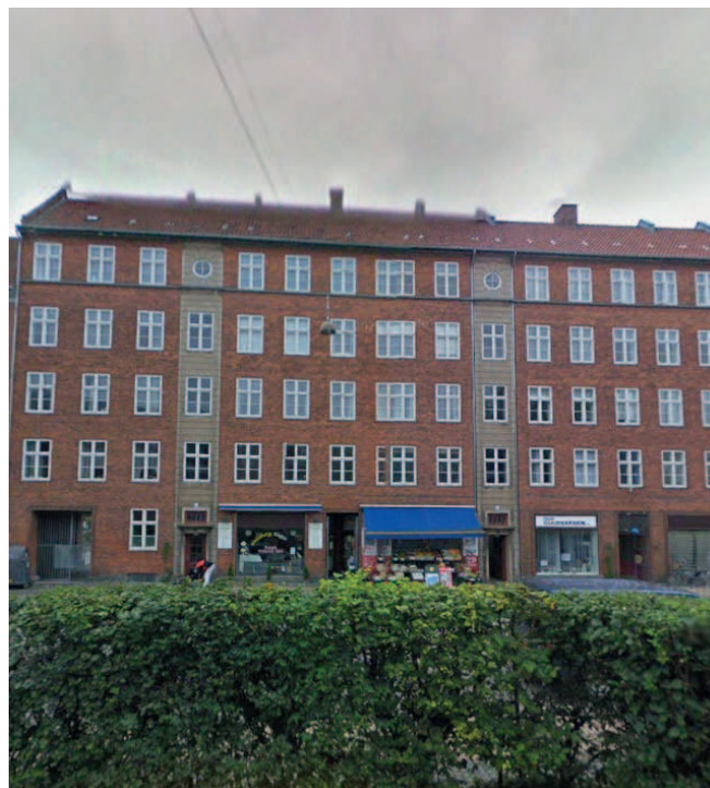
Ejendommen set fra gaden
