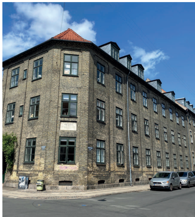
Ejendommen set fra gaden
