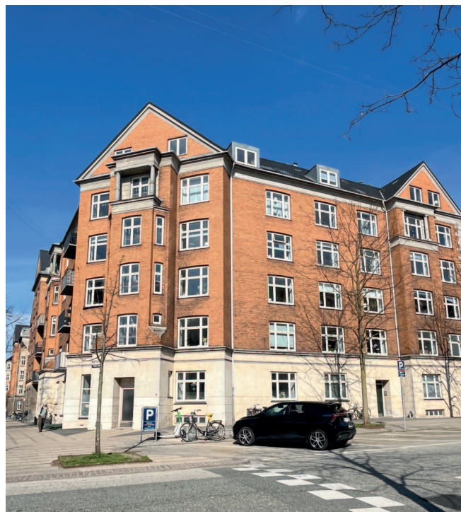
Ejendommen set fra gaden
