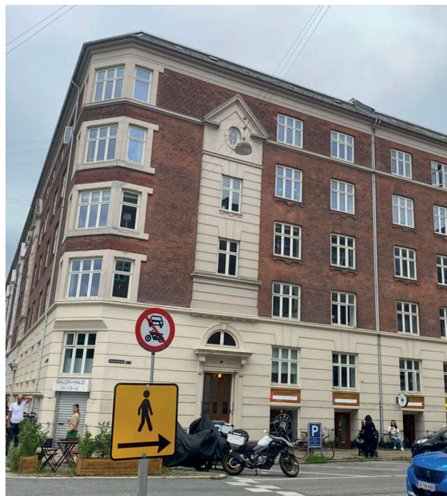
Ejendommen set fra gaden
