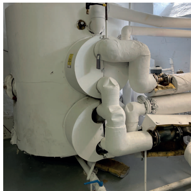
1-strengt varmeanlæg udskiftes til 2-strengt
