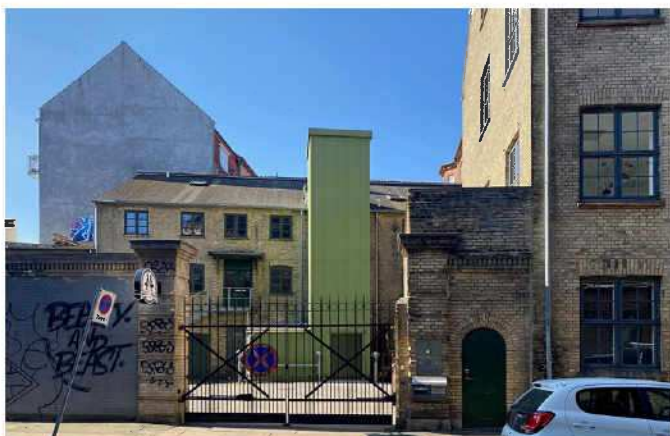
Kig fra Hannovergade mod indgangsparti.
