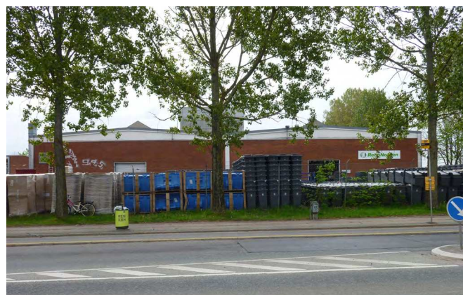
Bygningen set fra Kløvermarksvej
