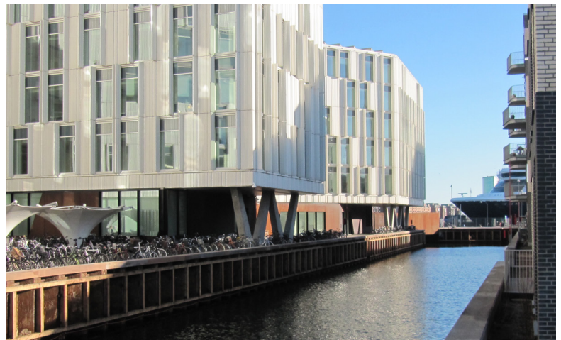
Kanalen mellem den østlige bolighalvø og FN-byen
