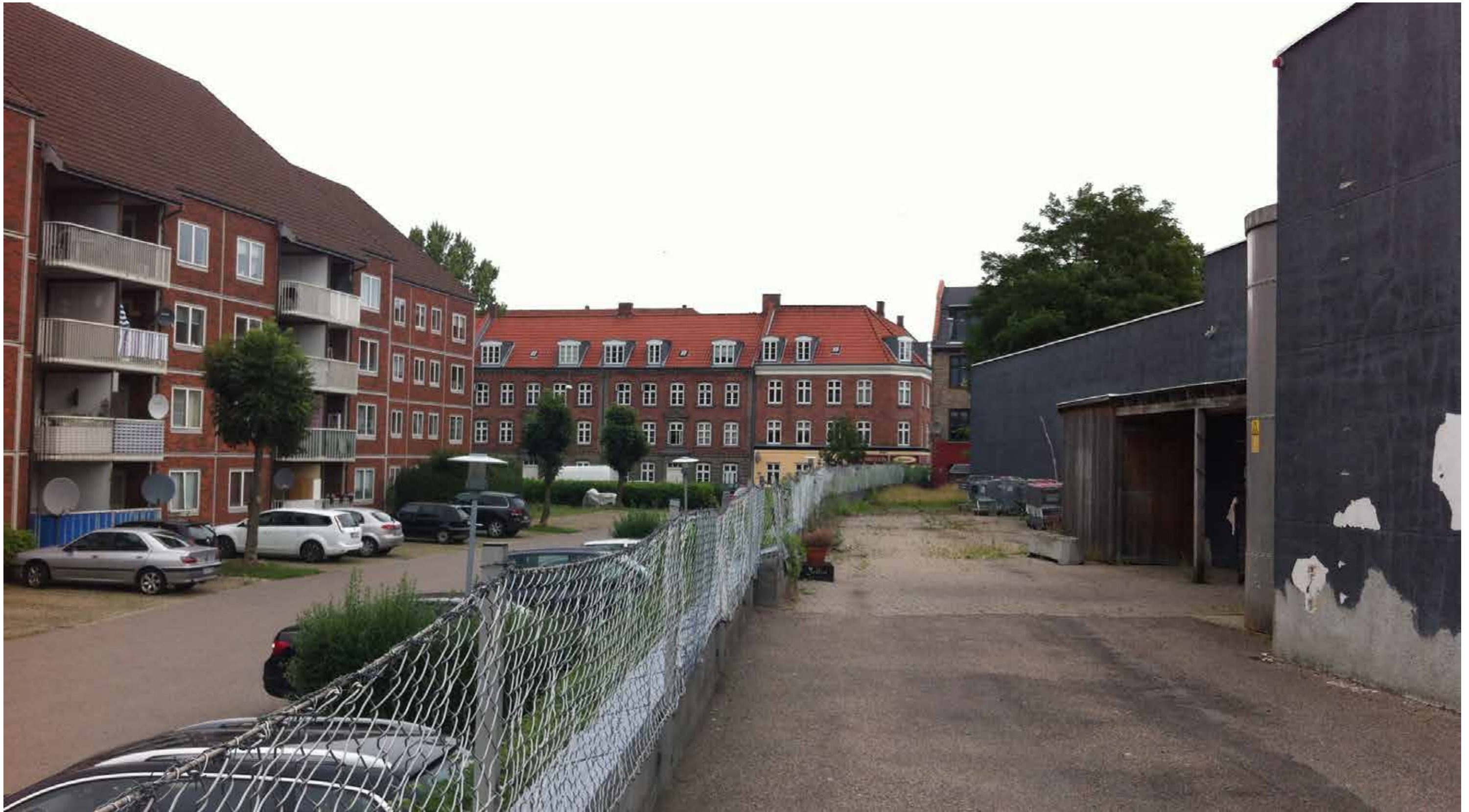
EKSISTERENDE SITUATION - NEDSLIDT BAGSIDE
