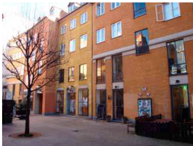
Butiksfacade mod gården Store Kongensgade 5B-19B.
