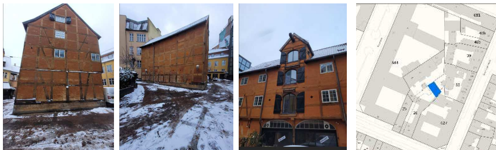
Baghuset Gothersgade 8 L
